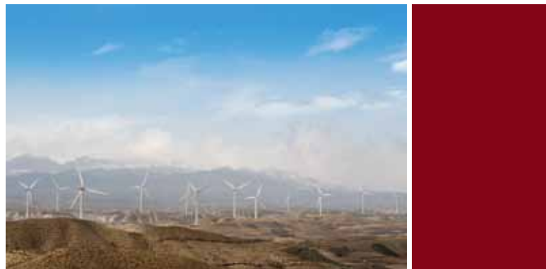
国投酒泉第一风电有限公司参与甘肃省酒泉市“陆上三峡”风电基地建设，其开发的瓜州北大桥东风电场2×49.5MW工程于2009年3月16日正式开工建设。2009年12月，国投酒泉第一风电有限公司被授予酒泉千万千瓦级风电基地建设“突出贡献奖”。
