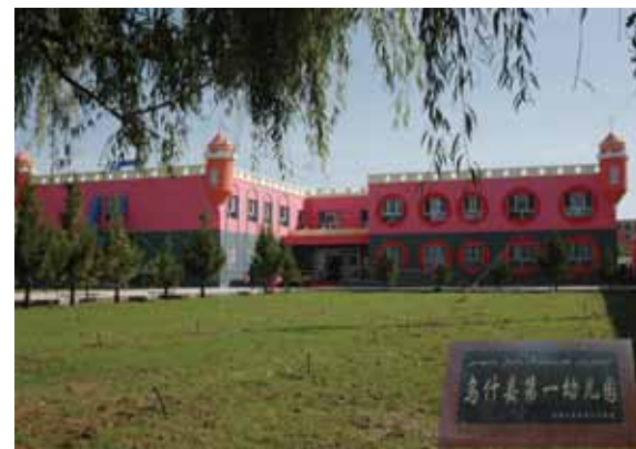
公司援建的乌什县第一幼儿园投入使用。
