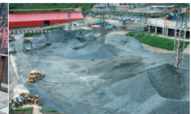
竹子坝砂石生产过程中的成品碎石仓。
