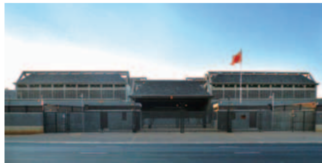
中成公司承建的中国驻南非使馆，是我国在非洲地区建设的最大驻外使馆。
