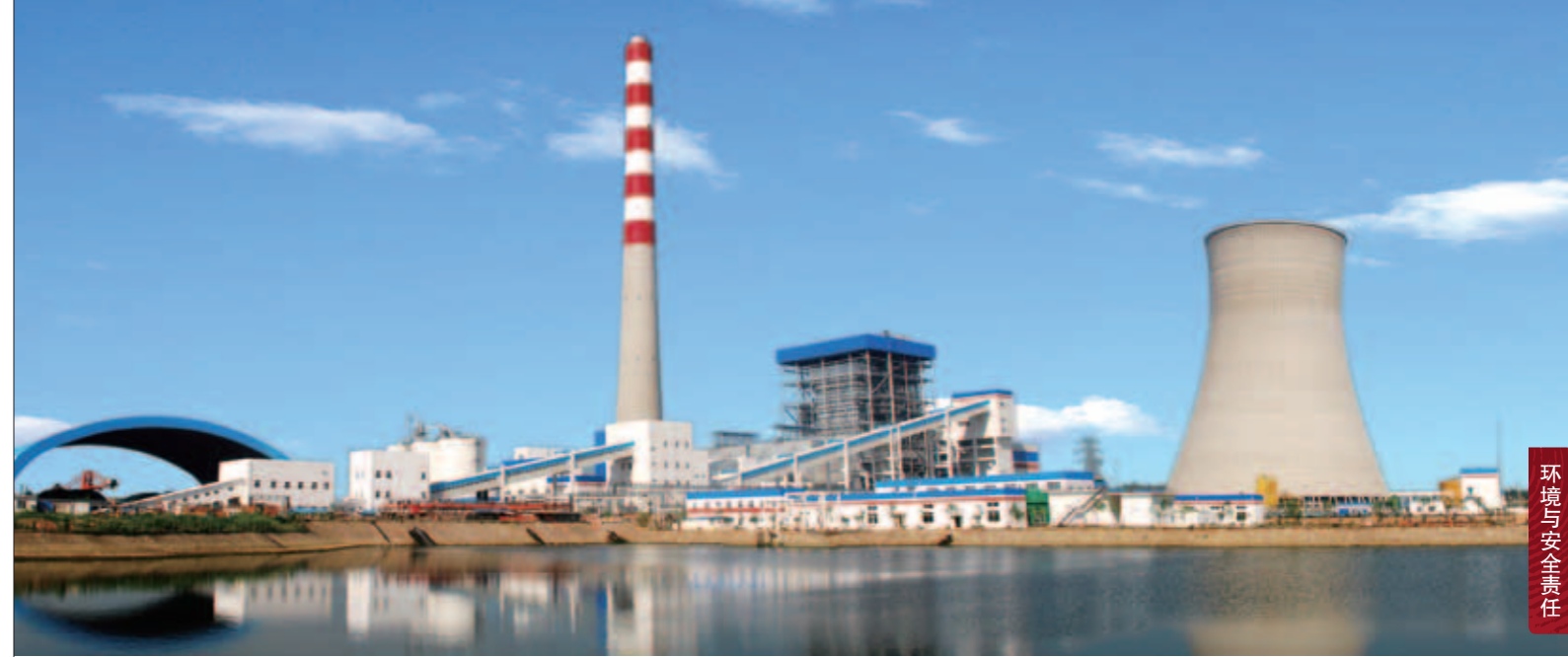
2010年国投宣城发电公司投资5925万元对机组进行脱硝改造。
