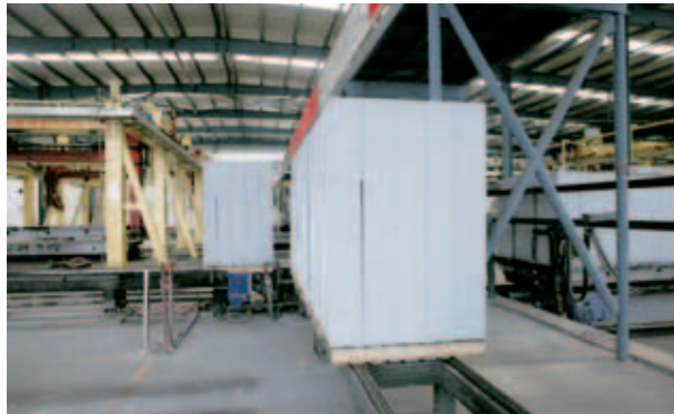
国投北疆电厂循环经济项目，利用发电环节产生的粉煤灰，年生产新型建筑材料 150 万立方米。
