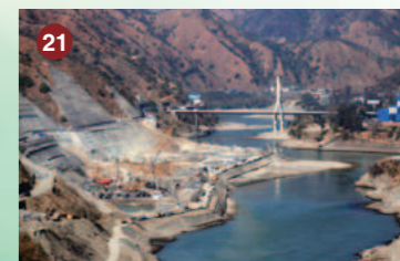
桐子林水电站
