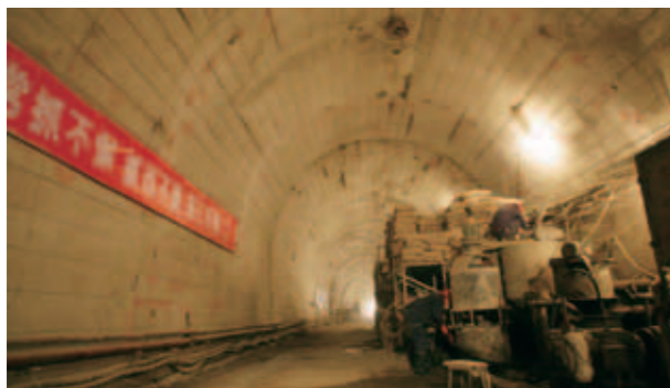
锦屏二级水电站左岸基础施工, 安全生产长抓不懈。
