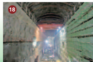
锦屏二级水电站
