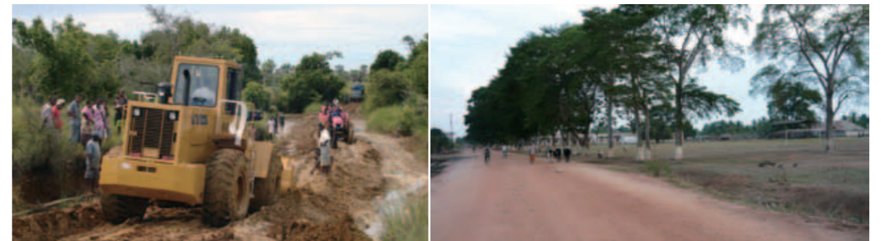
为改善项目所在地员工及周边村落人员的生活，中成公司牙买加那马吉亚糖联企业修护那马吉亚至东郭米那、米清竹的县级公路。
