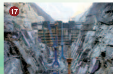
锦屏一级水电站
