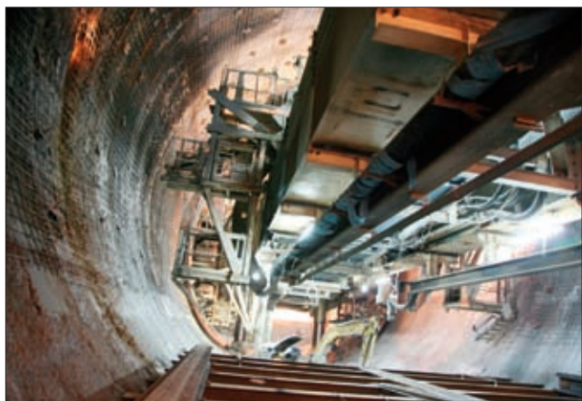
“穿越锦屏山”——锦屏山隧道施工 李玉成
