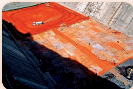
两河口水电站大坝心墙填筑
