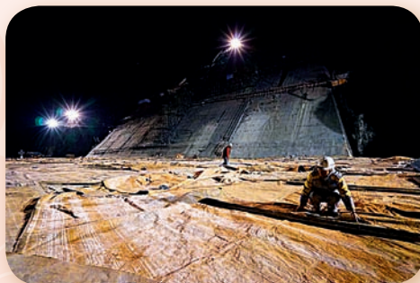
大年初一，两河口水电站大坝心墙盖被子
