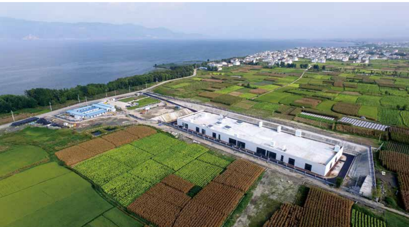
大理洱海古城下沉式再生水厂
