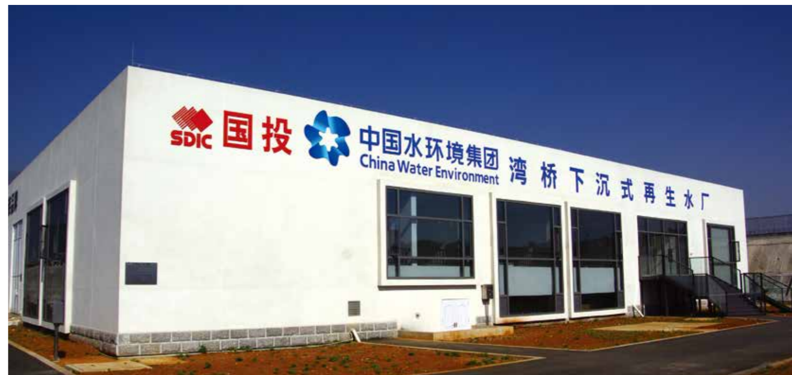
大理洱海湾桥下沉式再生水厂
