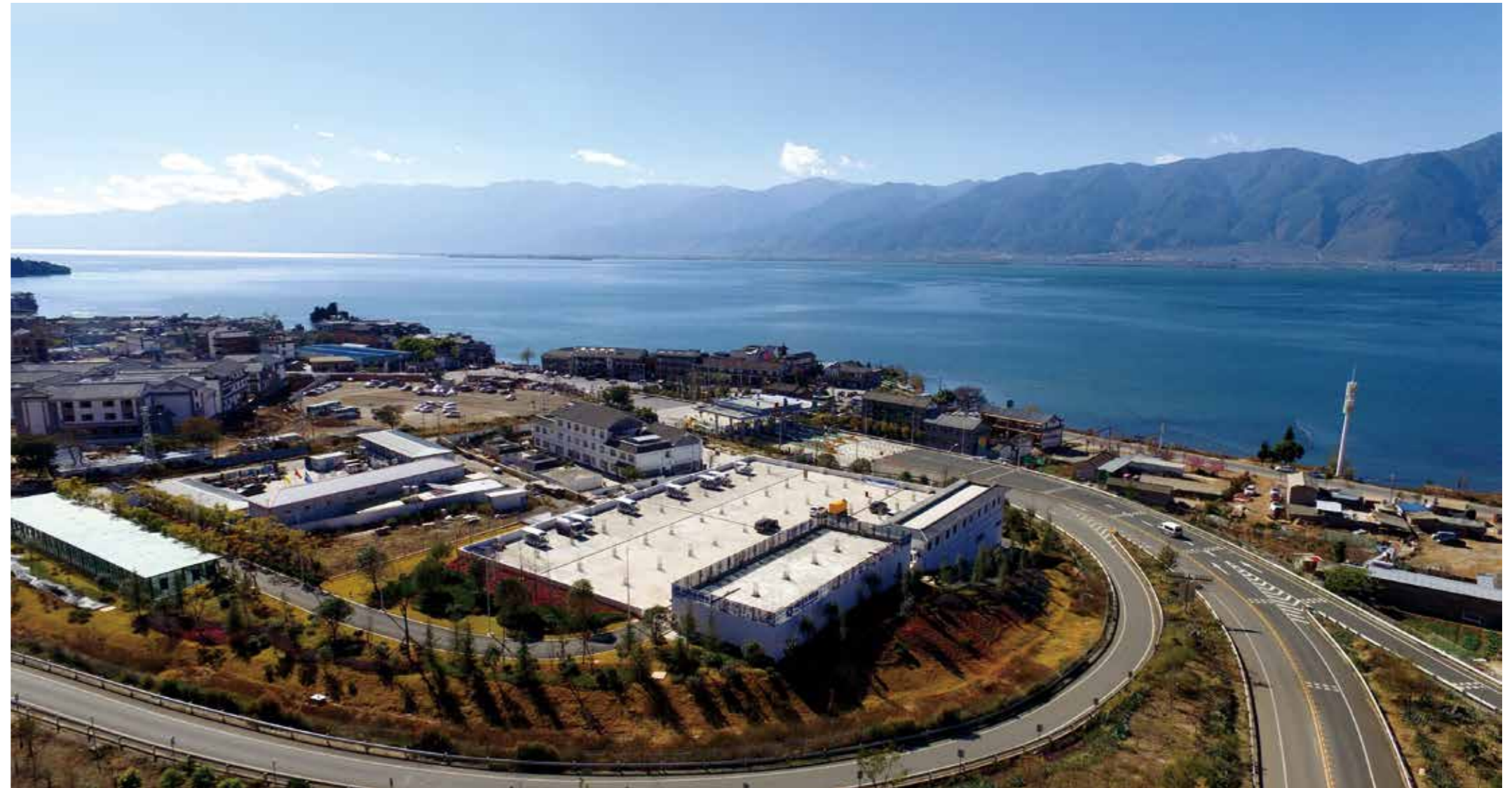
大理洱海双廊下沉式再生水厂
