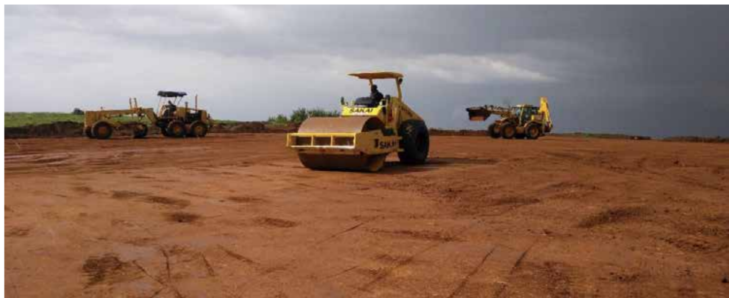
中成集团承建的乌干达药品仓库项目现场
