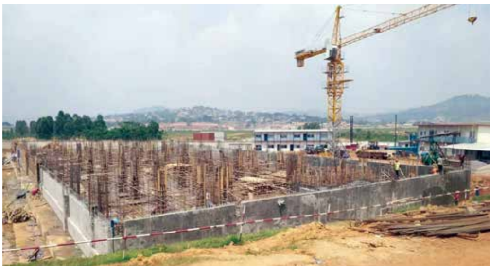
中成集团承建的乌干达药品仓库项目现场
